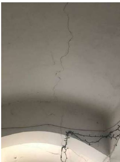
Slika: Razpoke na stropu hodnika (1.2).
