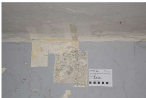
Slika: sonda (S 61) stena strop in (S 63) strop prostora 16 - Velike dvorane. Sonde kažeta na morebitno prisotnost poslikave.
