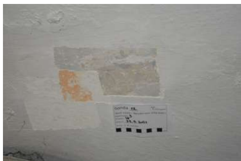
Slika: sonda (S 61) stena strop in (S 63) strop prostora 16 - Velike dvorane. Sonde kažeta na morebitno prisotnost poslikave.
