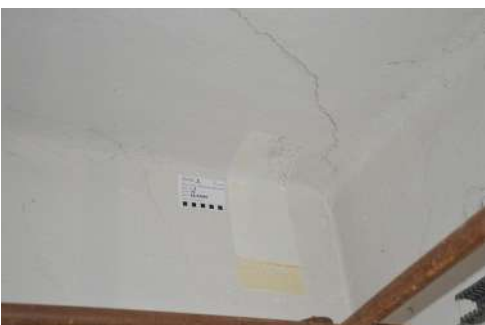
Slika: sonda (S 67) stena prostor 18 in sonda (S 69) cokol prostor 19. Sonde kažeta na morebitno prisotnost poslikave.
