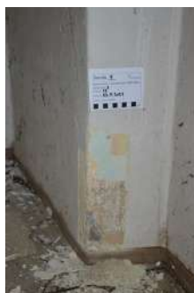
Slika: sonda (S 67) stena prostor 18 in sonda (S 69) cokol prostor 19. Sonde kažeta na morebitno prisotnost poslikave.
