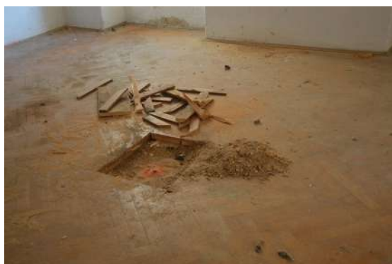
Slika: Mala dvorana (1.3) v 1. nadstropju nad južnim salonom (2) v pritličju; vidno peščeno nasutje.
