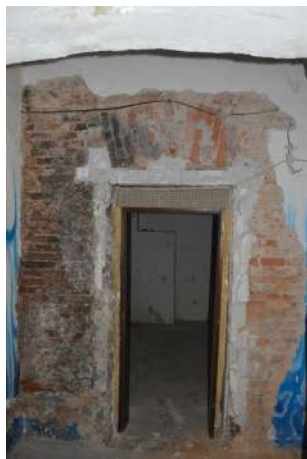
Slika: Hodnik (1) severni del in stopnišče v 1. nadstropje (6), kjer so odbiti ometi od opeke.
