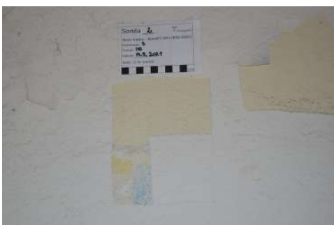
Slika: sonda (S 67) stena prostor 18 in sonda (S 69) cokol prostor 19. Sonde kažeta na morebitno prisotnost poslikave.
